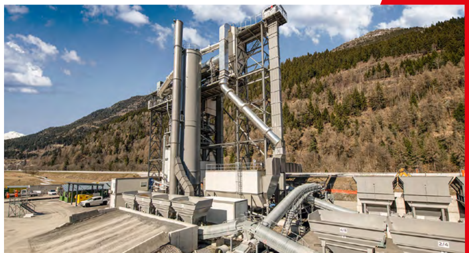
Un poste d'enrobage Ammann ABP HRT qui produira au total 250 000 tonnes d'enrobé sur le site.
