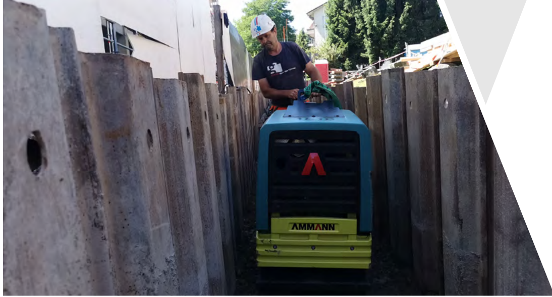
La compactadora de placas vibratorias hidrostáticas APH 65/85 cabe perfectamente en la estrecha zanja.
