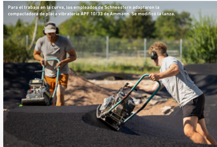
Un asidero adicional en la placa vibratoria facilita el difícil movimiento de la placa vibratoria en las curvas pronunciadas.
