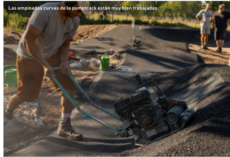
Para el trabajo en la curva, los empleados de Schneestern adaptaron la compactadora de placa vibratoria APF 10/33 de Ammann. Se modificó la lanza.
