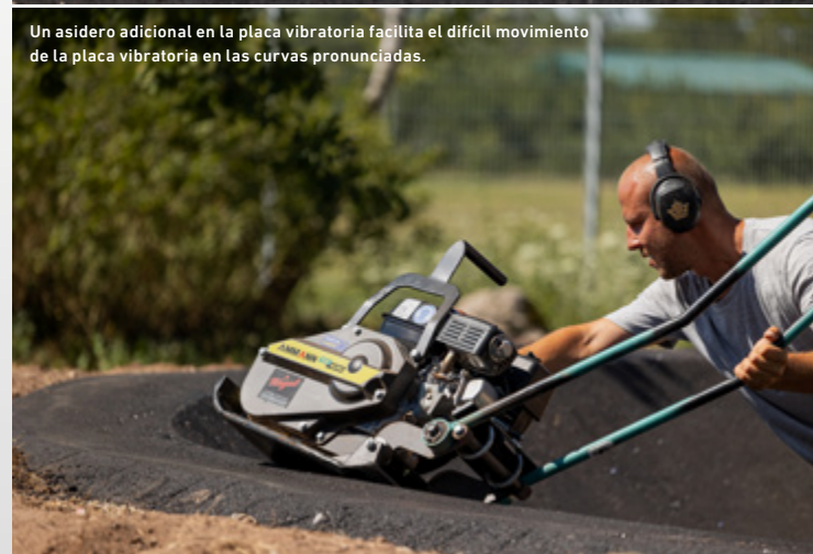
La placa fue rectificada en forma convexa. Esto permite modelar perfectamente las curvas.
