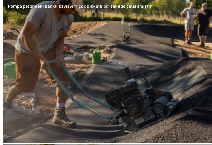
Schneestern çalışanları kavis üzerinde çalışmak için, Ammann'ın APF 10/33 titreşimli plakasını ayarlamıştır. Çeki demiri hareket ettirildi.
