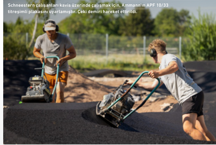
Titreşimli plaka üzerinde yer alan ilave kol, dik eğimli eğrilerin zor kısımlarındaki hareketini kontrol etmeye yardımcı olur.
