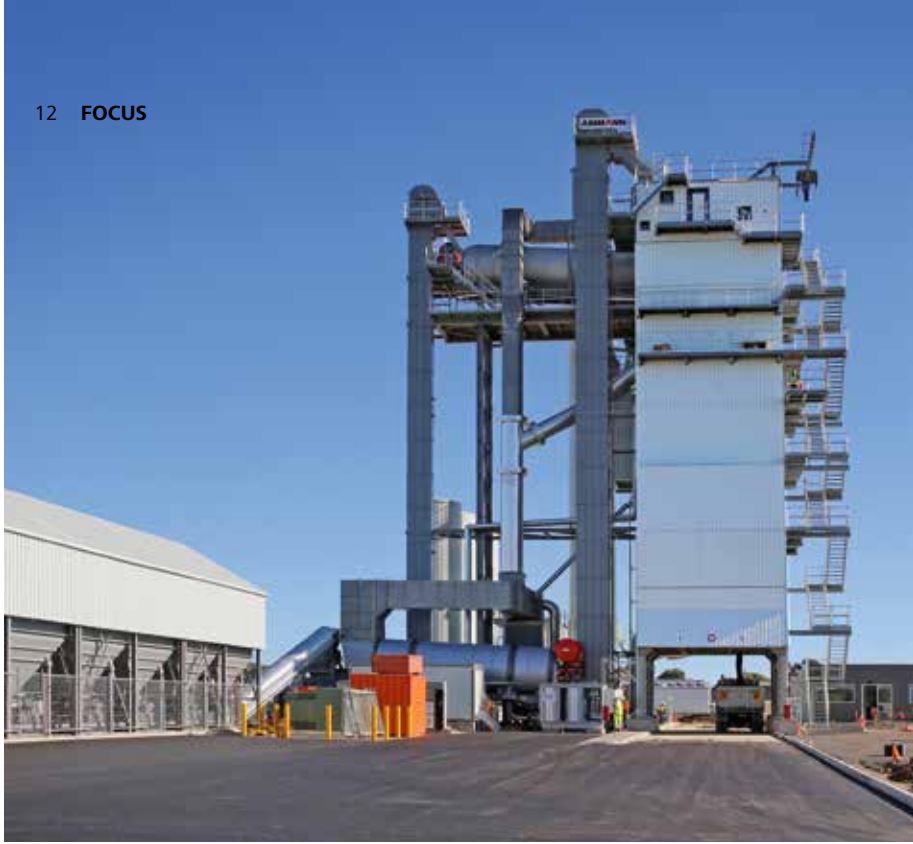
La première installation HRT a attiré les visiteurs du salon Bauma à Munich comme un aimant et a été remise, pendant le salon, au client australien Downer.
